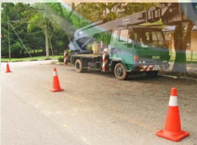
Gambar 57: Meletakkan kon keselamatan semasa kerja pemangkasan di tepi jalan.
