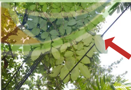
Gambar 36: Dahan atau ranting yang menyentuh talian utiliti hendaklah dipangkas segera oleh pekerja mahir
